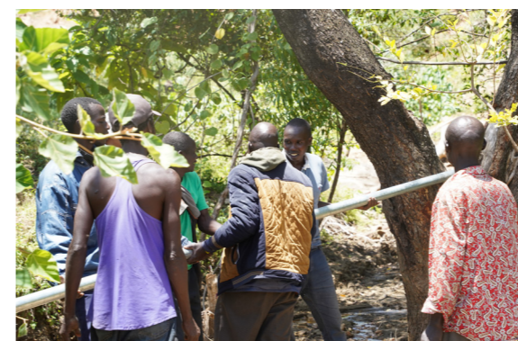
汲水泵透過壓力原理將瀑布底下的水打上山頂
